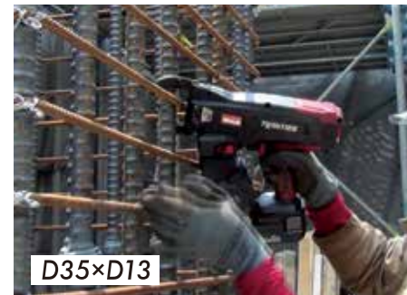
建築の梁・柱にも使用。
