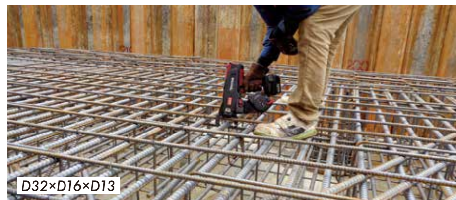
土木現場・建築現場のより太いスラブ現場でも。
