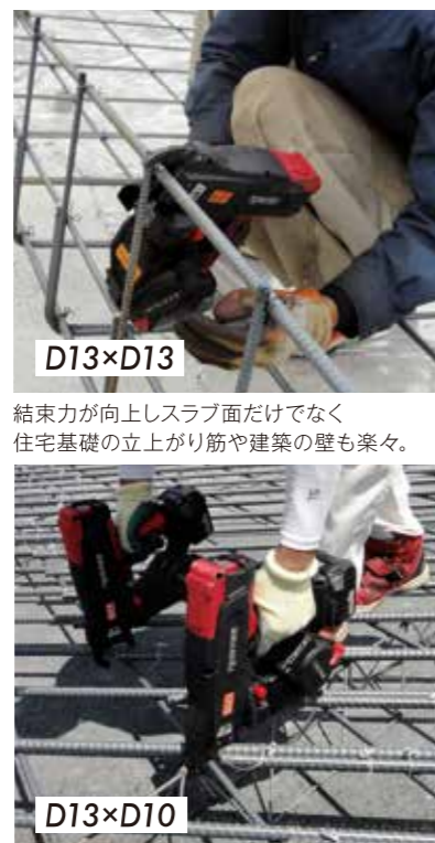
高速道路床板の鉄筋結束作業も 2台同時使用でスピーディーに。
