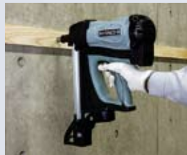
●木材の留め付け
