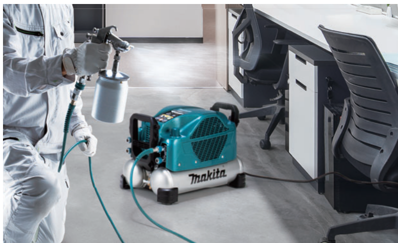
各種吹付け作業に
