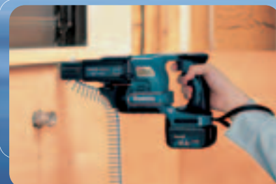
●コンパネ、合板を木下地へ
