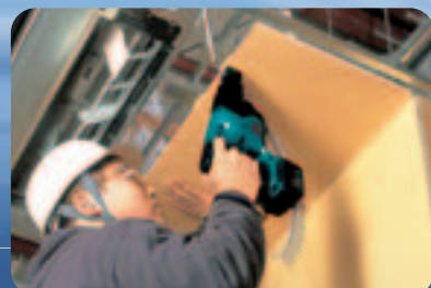
●石こうボードを鋼製下地へ
