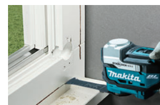
4 窓枠の取り外し
