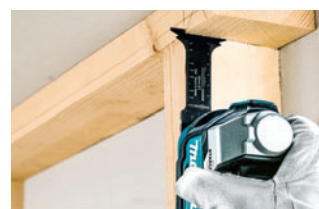
2 外枠調整の面一切断
