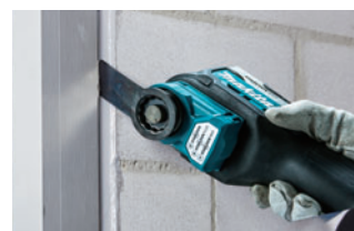
7 弾性シーリング除去作業
