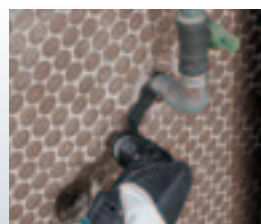
6 金属管の切断
