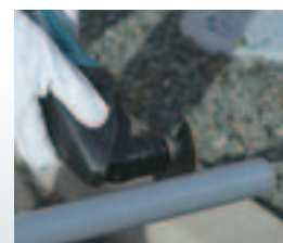
9 塩ビ管の切断
