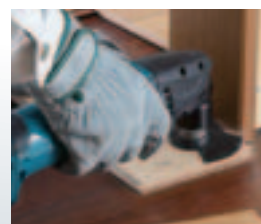
8 仕上げ材の切断(床材納め)
